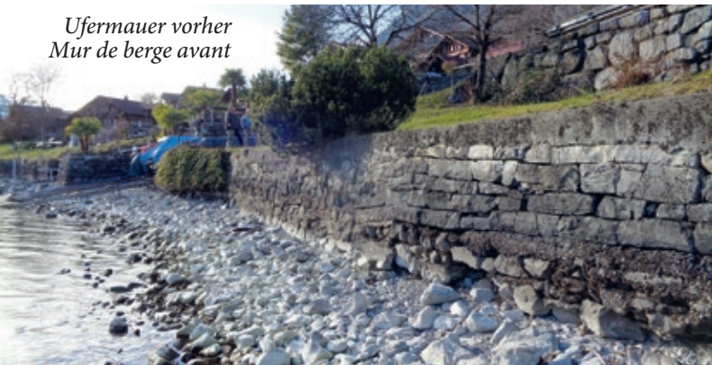
Während des Baus Pendant les travaux
